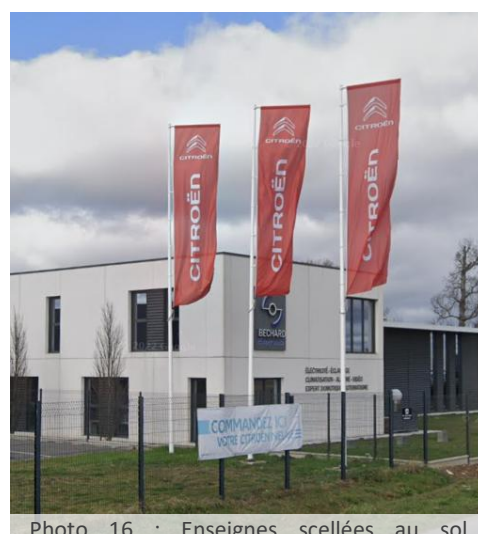
Photo 16 : Enseignes scellées au sol (oriflammes) dans la ZA de la Ménude, à Plaisance-du-Touch - StreetView
