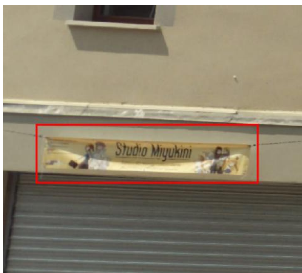
Photo 95 : Enseigne sur banderole, parallèle à la façade, pl. du 8 mai 1945 à Léguevin - SOGEFI
