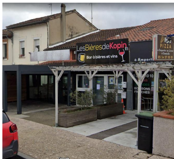
Photo 94 : Enseignes sur toiture, av. de Gascogne à Léguevin - SOGEFI
