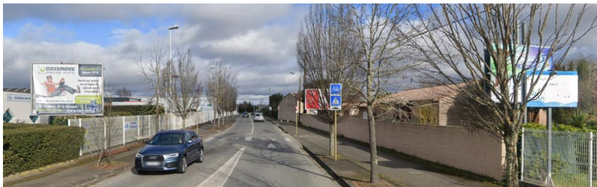
Photo 122 : Insertion paysagère de dispositifs scellés au sol, avenue des Capitouls – StreetView
