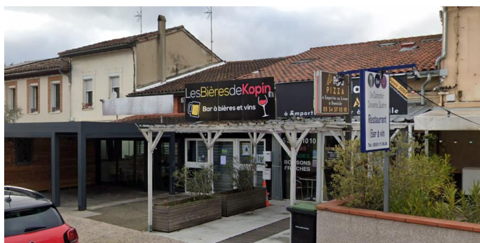
Photo 30 : Enseigne sur toiture, av. de Gascogne à Léguevin - SOGEFI
