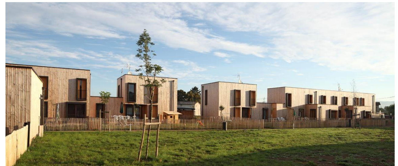
20 maisons individuelles groupées – BIROUDE (43) Source : Atelier du Rouget
