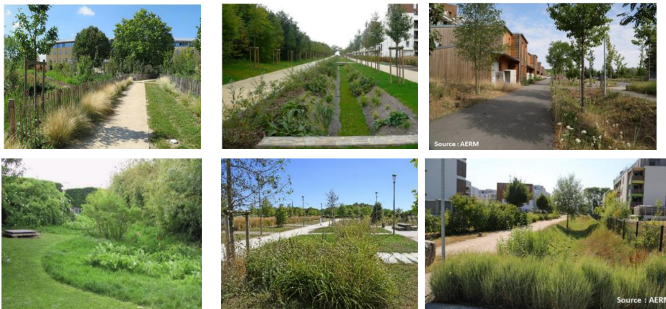
Figure 9 Exemples d'aménagements de voies douces, de noues végétalisées et de bassins d'orage, source AERM
